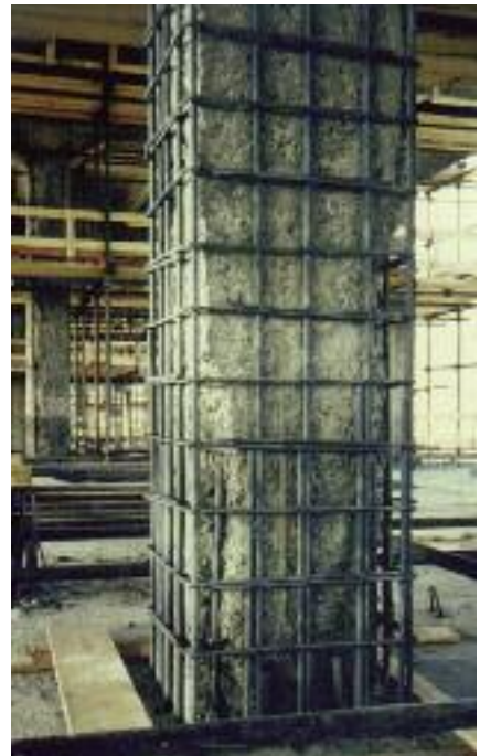
Travaux de consolidation des piles d'un viaduc (Italie).
